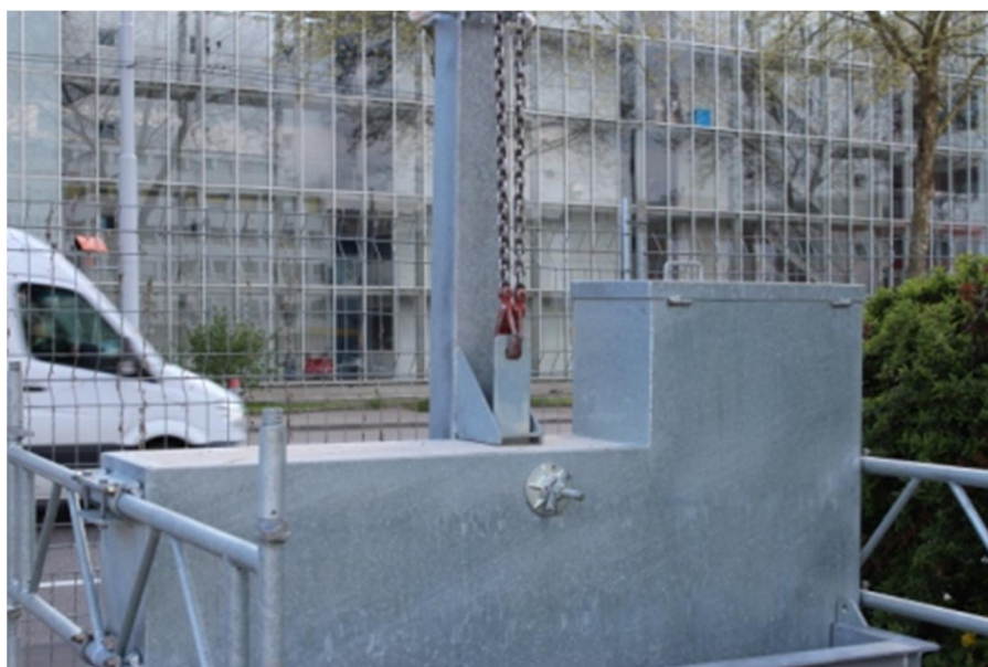
Anschlag Krankette an Betonsockelhaken
