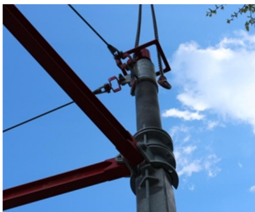
Einfahren der Krankette durch das Kammblech
